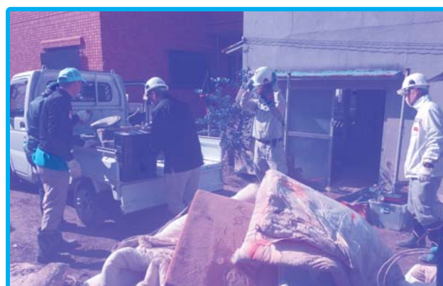
▲解体予定の家屋からの家財搬出を行っています。
